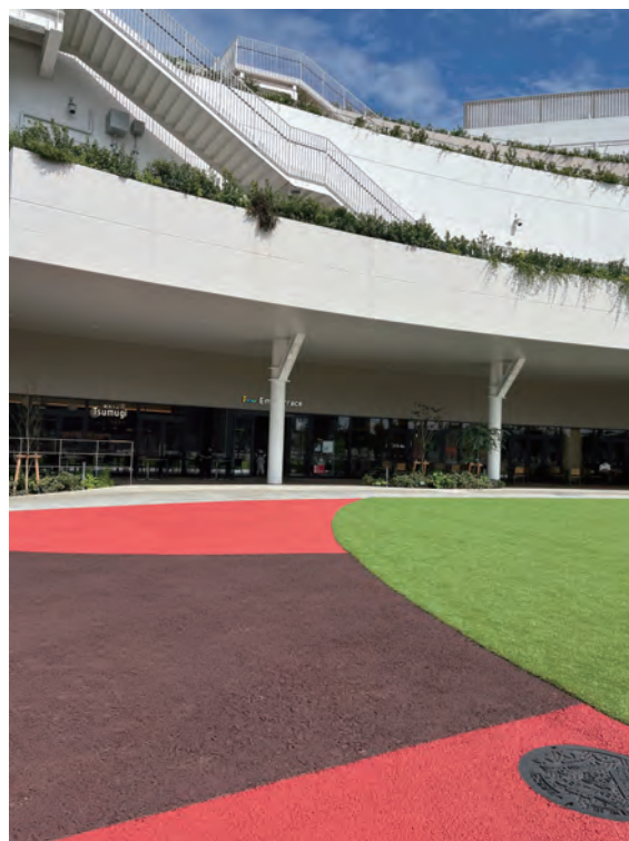
駅前商業施設に敷設された木質舗装歩道
