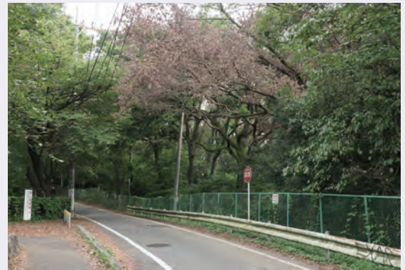
道路脇の危険木
