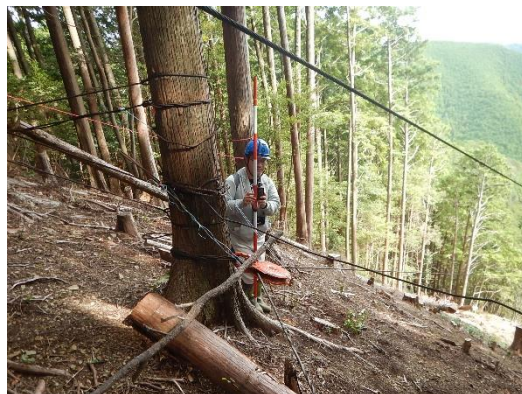
＜先柱の位置確認＞
