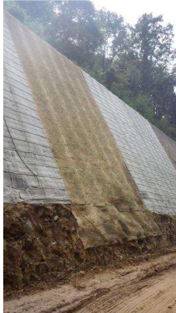
日南町での施工状況
