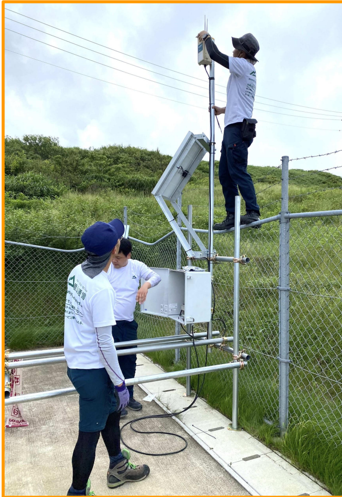
最もバッテリーが大きいタイプでも単管パイプだけで設置可能
