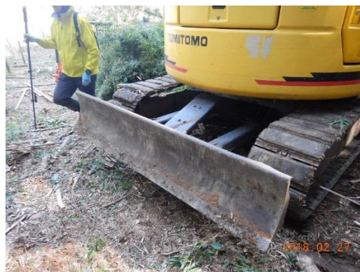
図 4.11 ベースマシンに取付けられた排土板とゴム装着クローラ（拡大図）
